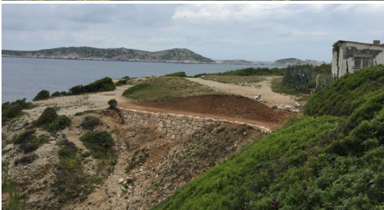
Réalisation d'un mur de soutènement à Marseilleveyre avant / après (haut / bas)
