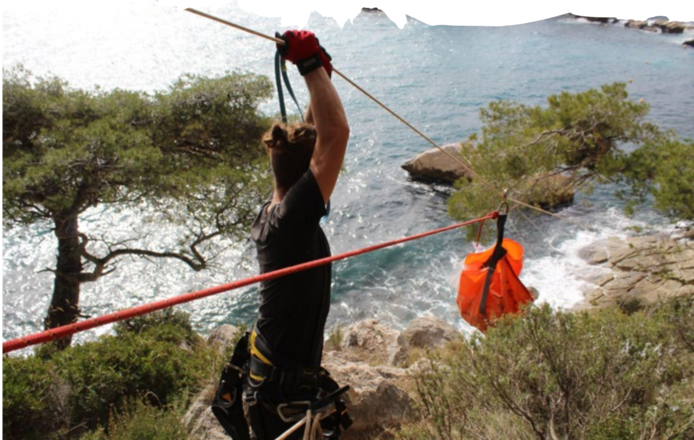
Évacuation des rémanents par tyrolienne, chantier de Sugiton/Pierres Tombées
