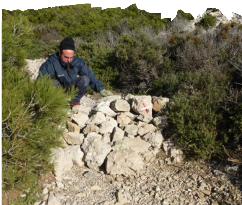
Travaux légers de fermeture de sentes par blocs rocheux sur le secteur Callelongue-Marseilleveyre (CD13), à droite par poteaux fils et débris végétaux à Sugiton (Ville de Marseille)
