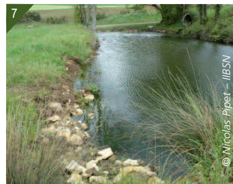
7- Mare après intervention le 3 mai 2012.
