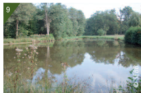
8- Étang immédiatement avant travaux (2008). 9- Étang en 2012.
