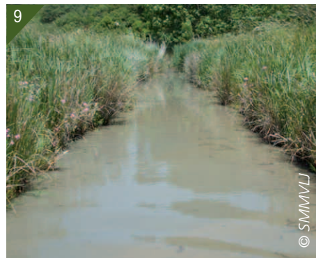
8- Fossé avant arrachage manuel. 9- Fossé après arrachage manuel.
